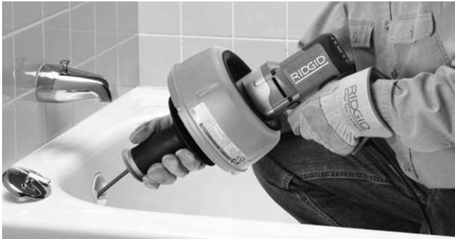
Obrázok č. 9 – Zatláčanie kábla do potrubia odtoku
