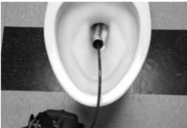
Obrázok 25 – Použitie flexibilnej navádzacej trubice
