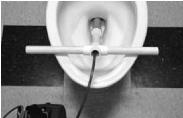
Obrázek 24 – Použití zaváděcí trubky z PVC
