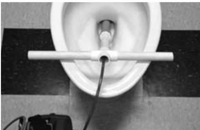
Obrázok 24 – Používanie navádzacej PVC trubice
