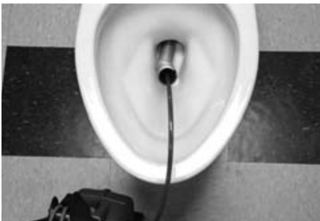
Obrázek 25 – Použití pružné zaváděcí trubky
