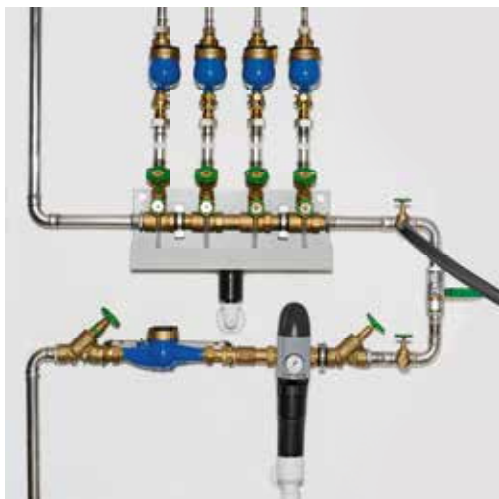
Tlaková zkouška a kontrola těsnosti pomocí vody
