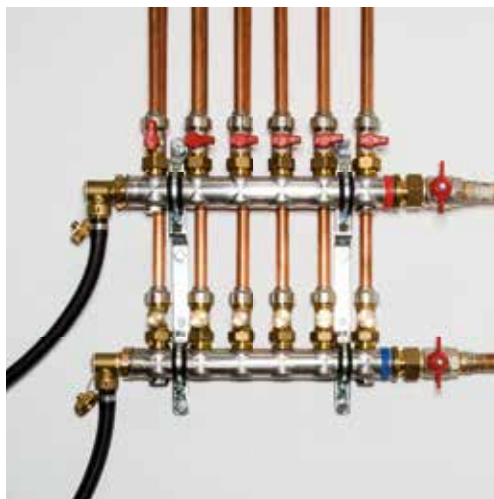
Proplachování radiátorů a plošných topných systémů
