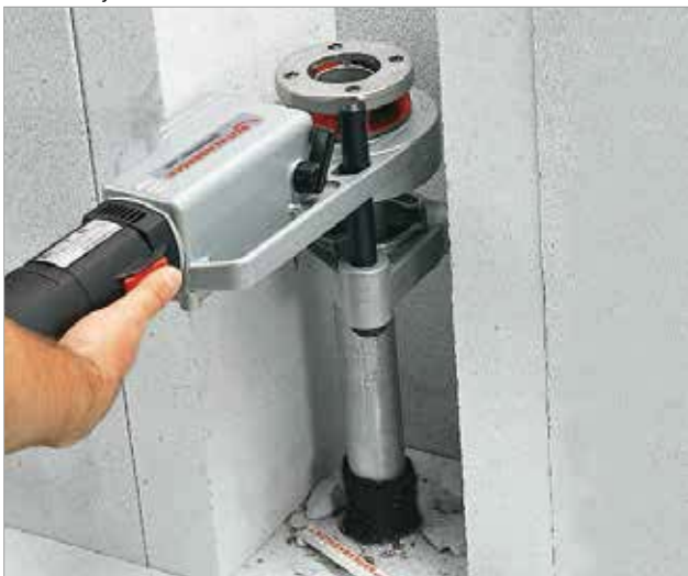
Práce v úzkých místech
