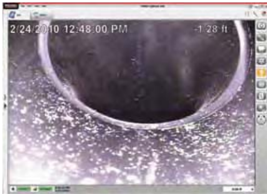
Sledování a záznam inspekci.
